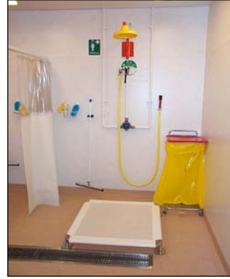
Exempel på fast saneringsanläggning, Kärnsjukhuset Skövde
