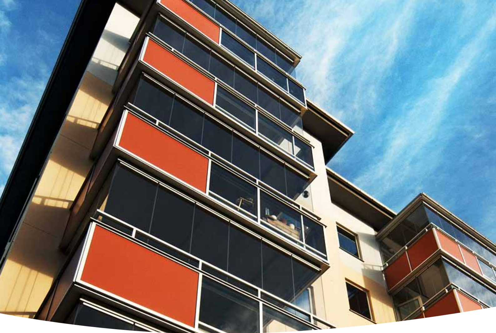
Passivhus på Malmsättersgatan i Kinna.
