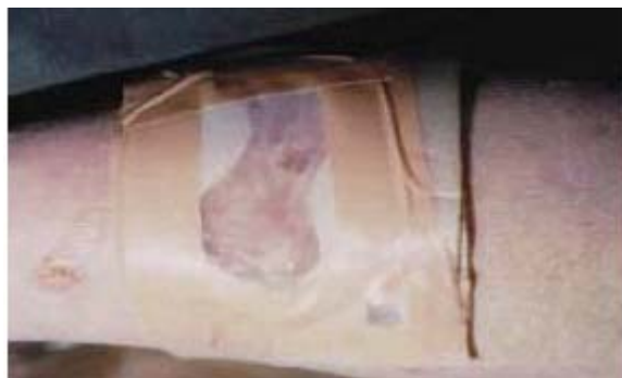
Bild 55. Nätet fästs med Sleek-tejpen. (Foto: Carita Hansson)
